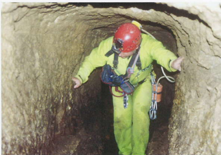
All'interno della Galleria Marsiliana, Piano del Lago, sulle pareti della galleria sono state scavate delle piccole nicchie, disposte in maniera regolare, foto archivio personale di M. Negri.
